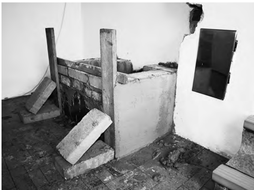
Obr. 15 Hrubá omítka a vytvoření rohu
