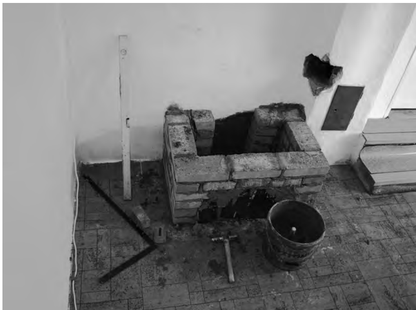
Obr. 14 Hrubá stavba podstavce
