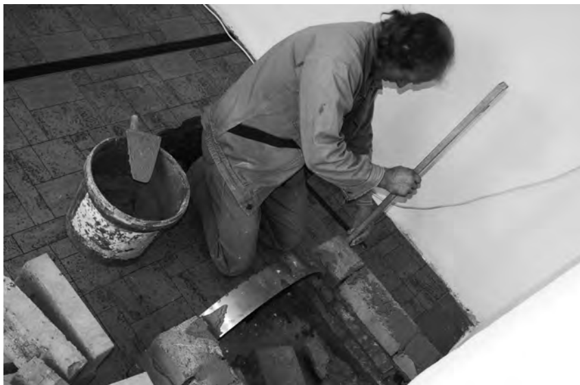
Obr. 12 Realizace v praxi – stále kontrolovat roviny
