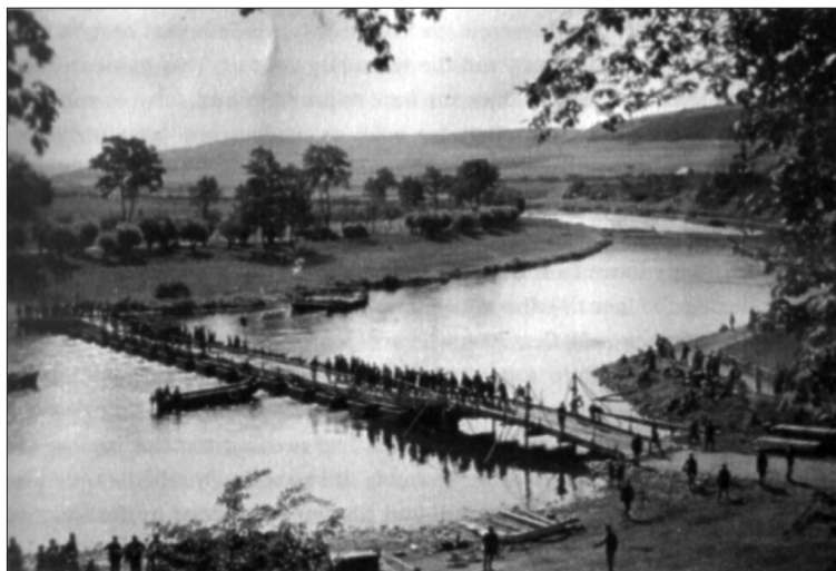
Pontonový most postavený ženijním praporem Rudolfa Witziga během manévřů v roce 1937.
