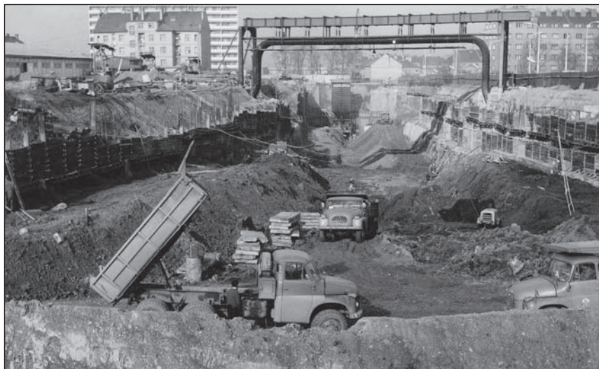
Nejvíce geologických poznatků o geologii Prahy přinášejí železniční a silniční zářezy a tunely. Výkop stanice metra Pankrác. Foto J. Kříž
