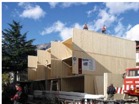
Obrázek 4 Příklad z realizace budovy z CLT panelů
