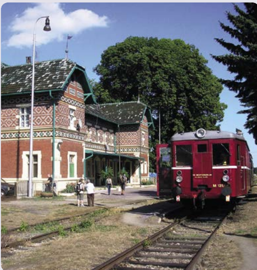
▲ Zajímavou stavbou je lednické nádraží, na jehož obklad byly využity výrobky místních keramických závodů
