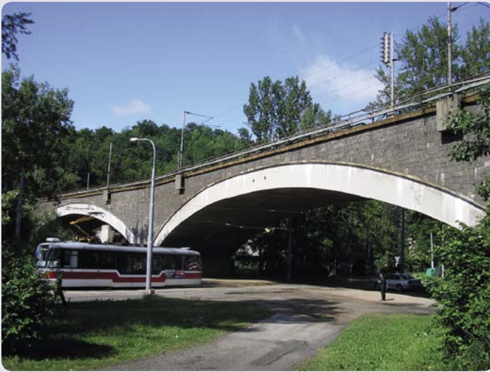
▲ Trať mezi Brnem a Prahou budovaná v letech 1939–1953 má na své trase několik zajímavých staveb. Jednou z nich je dvouobloukový most v Brně–Obřanech, na jehož soklu z jižní strany měly být původně dokonce osazeny sochy.
