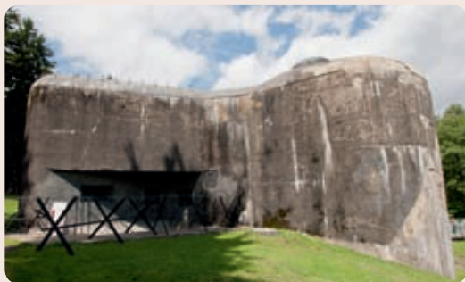
Prohlídka nedokončené tvrze Skutina probíhá v pěchotním srubu U stodol.
