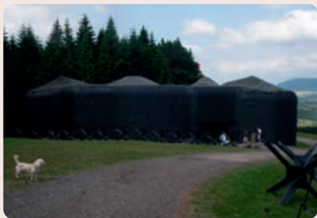
Prohlídka tvrze Stachelberg začíná v pečotním srubu Polom, jednom ze tří největších objektů našeho těžkého opevnění.
