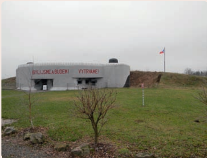
Pěchotní srub U cihelny
