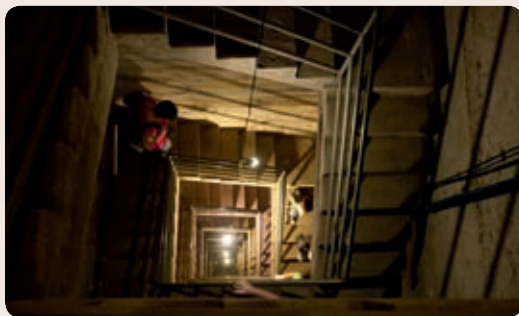
Schodišťová šachta do podzemí tvrze Skutina
