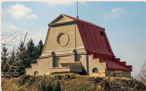
Vodovod čerpal vodu z rynholeckého uhelného dolu Laura.
