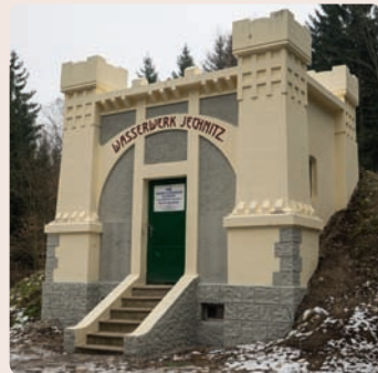
Druhá vodárna se nachází 250 m nad první ve svahu a svými věžičkami připomíná hrad.
