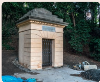
Altán je nově opravený.
