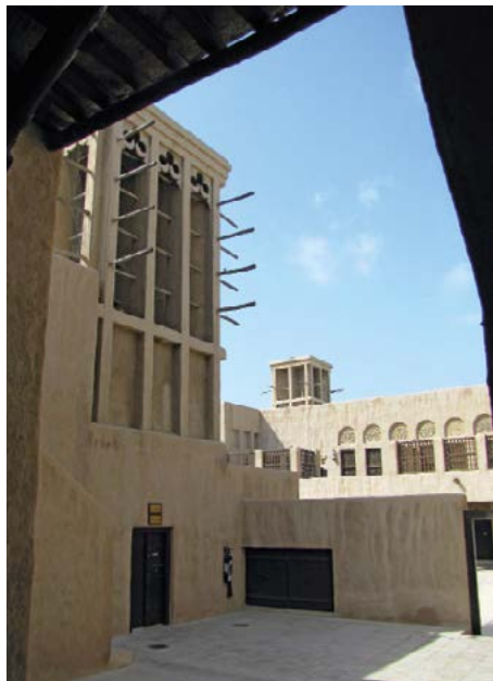
Větrné věže, které sloužily pro ochlazování staveb v pouštním klimatu. Ve starověku byla jejich účinnost zvyšována napojením na kanáty vedoucí v podzemí vodu. Dubaj, 2011.
