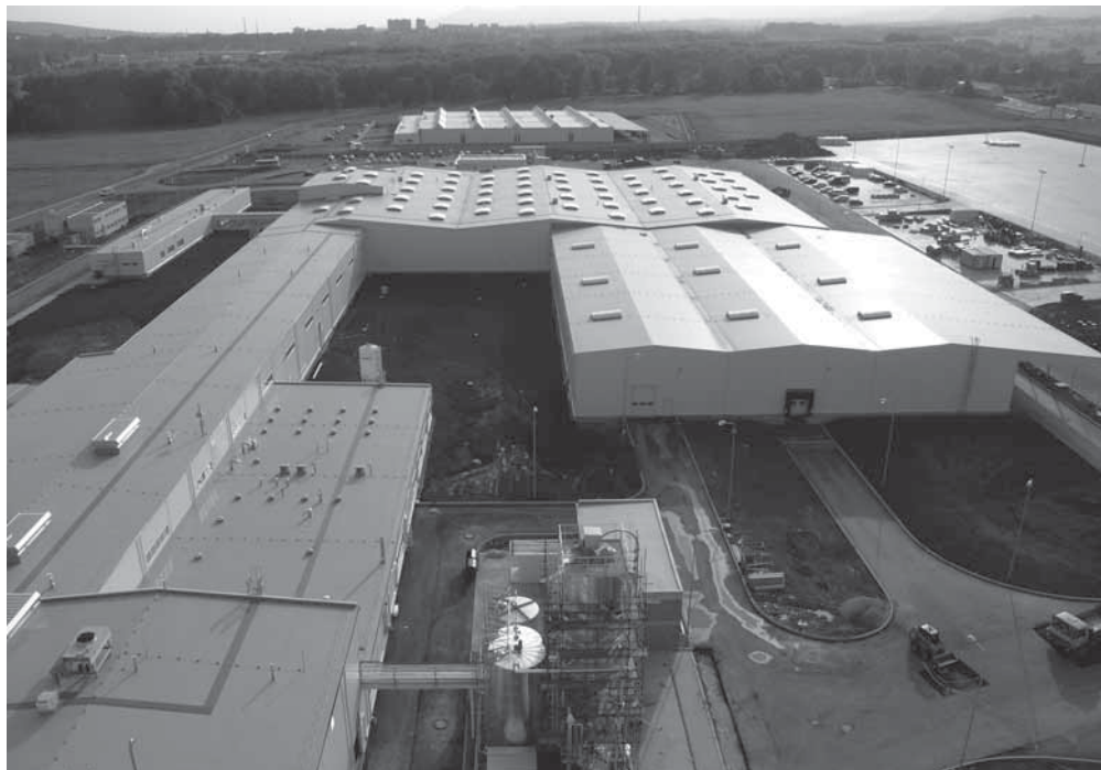
Obr. 1.3 Vodotěsná izolace z hydroizolační fólie RHENOFOL na areálu firmy KNAUF (foto FDT)
