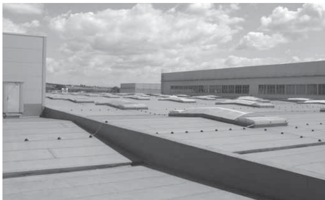
Obr. 1.2 Vodotěsná izolace z asfaltových pásů VEDAG – hala M14 ve Škodě Mladá Boleslav (foto VEDAG – ČR)
