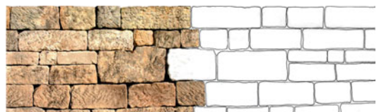
e) nepravidelné vrstvené zdivo
