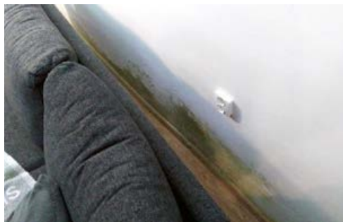
Obrázek 8 Sedací souprava, která se dotýká stěny, brání ohřevu povrchu stěny teplým vzduchem z místnosti a v chladných měsících roku zpravidla vytváří nežádoucí efekt vnitřního zateplení – na povrchu stěny vzniká kondenzát a následně plísně.
