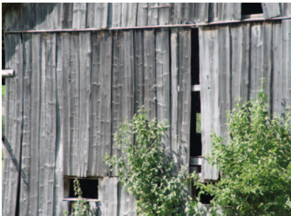
Obr. 1.10 Fasáda z fošen na hospodářském stavení. Funkce byla na prvním místě, použila se taková prkna, která byla momentálně k dispozici. Strukturální vady byly samozřejmě opraveny.
