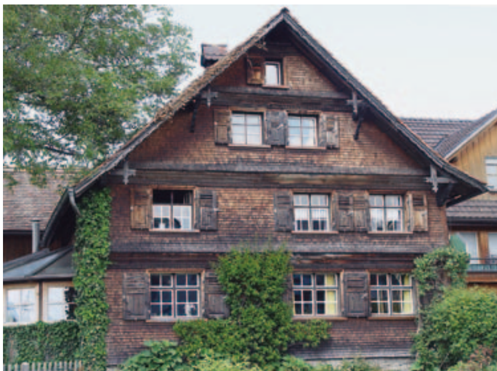
Obr. 1.9 Dřevěná fasáda ve Vorarlbergu. Fasáda z dřevěných šindelů umožňuje krytí poschodové římsy, což chrání okna před vlivy počasí. Velký přesah střechy způsobuje typicky různý stupeň zešednutí.
