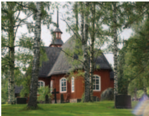
Obr. 1.1 Finský roubený kostel z 18. století. V severovýchodních zemích se donedávna využívalo jako povrchového nátěru směs volské krve a vápna.
