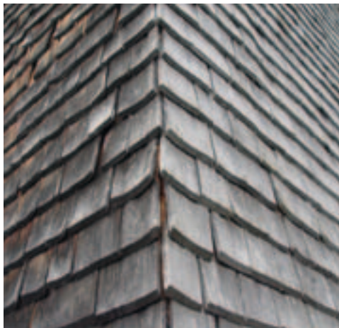
Obr. 1.8 Fasáda z dřevěných šindelů je pracná a na dřevo dost náročná fasádníká práce (překrytí cca 50–66 %). Vzhledem k malým rozměrům šindelů se rohy, úžlabí a přechodová místa provádějí poměrně snadno a jednoduše.
