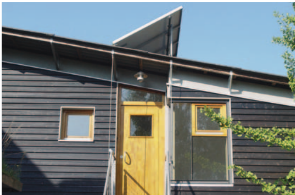
Obr. 2.9 Rodinný dům autora má dřevěnou fasádu natřenou černým lazurovacím lakem a je názorným příkladem typického konfliktu v průběhu výstavby: na jedné straně elegantní barva, na druhé straně vyšší tepelná expozice a kratší intervaly údržby. Pro barvu se můžeme zodpovědněji rozhodnout, když si uvědomíme tyto důsledky.
