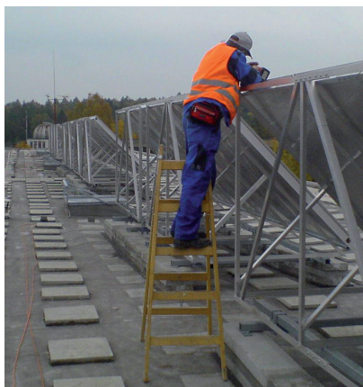
Obr. 1.3 Dokončovací práce na kolektorovém poli, foto archiv TWI-Merops
