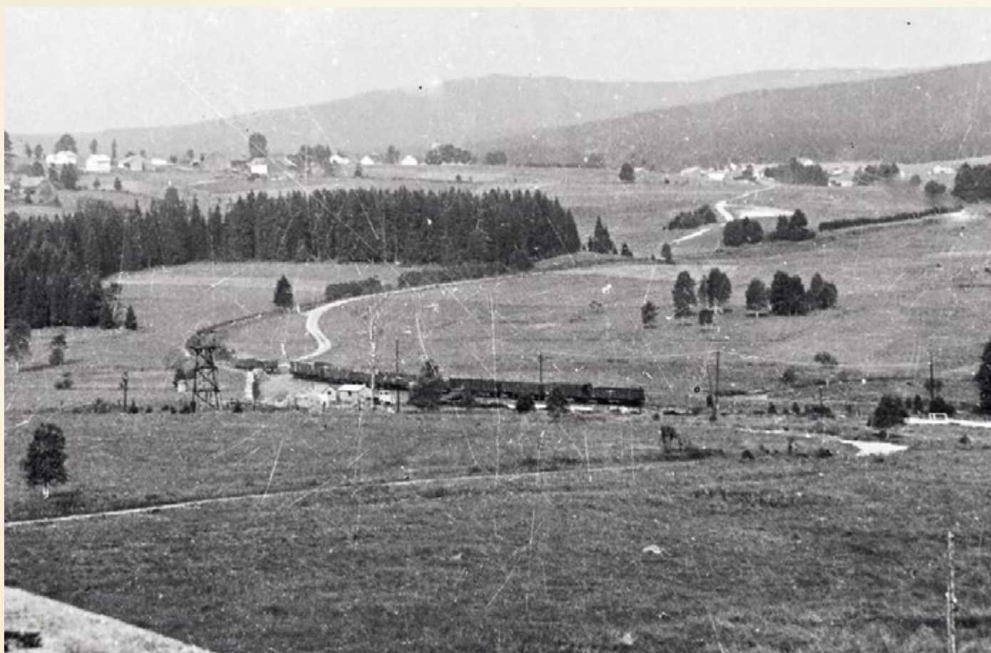
Obrázek ze stejného místa detailně ukazuje, že vozy jsou přistaveny až za drátěnými zátarasy. Foto Ivan Šafr
