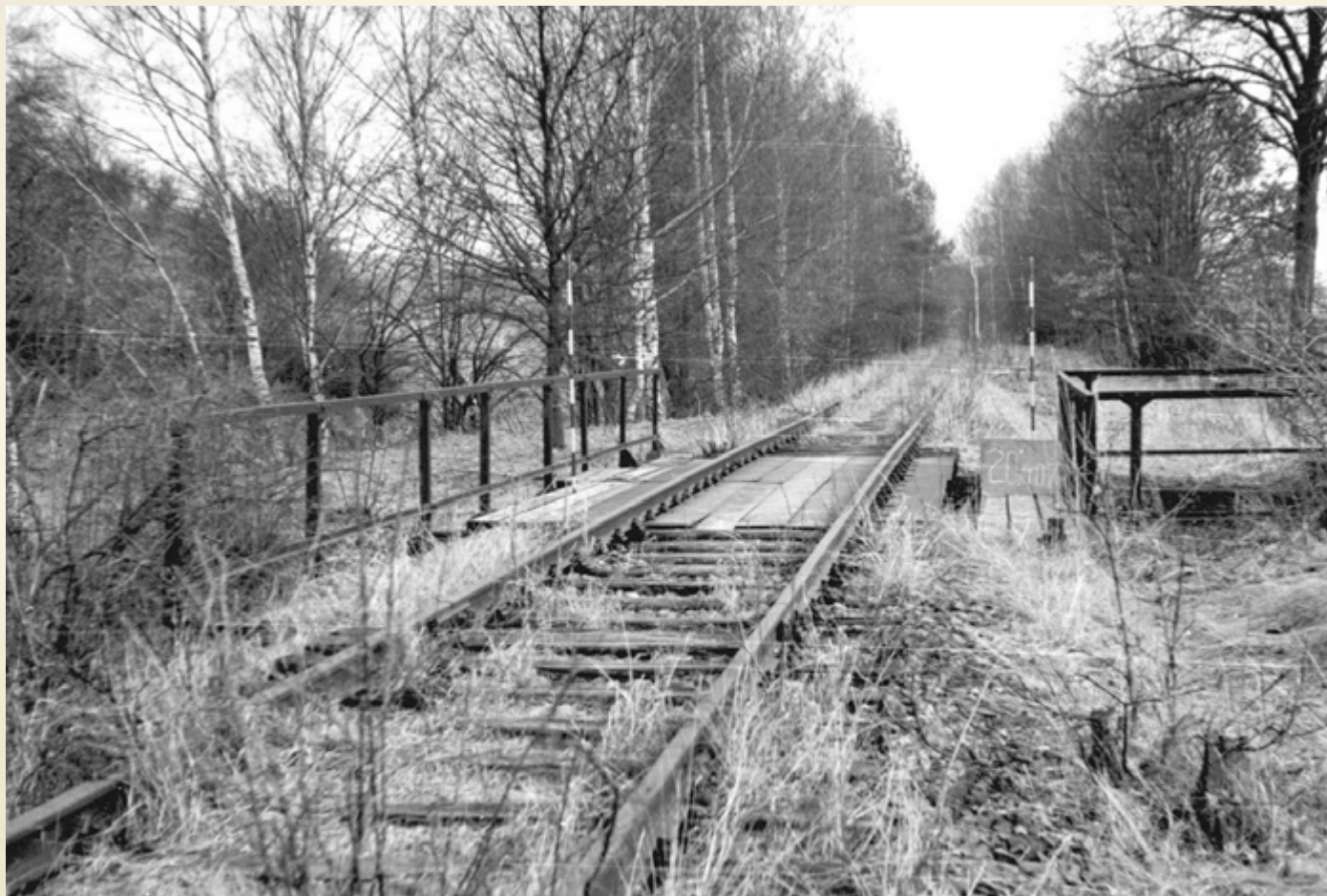
Koleje na mostě v km 20,407 v roce 1977, sbírka Roberta Koutného.
