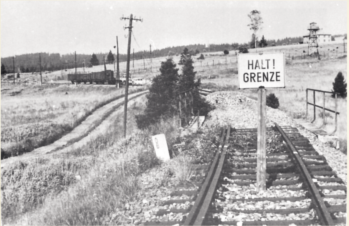
Fotografie z počátku padesátých let pořízená z německé strany hranice. V popředí je vidět hraniční kámen, most přes Údolský potok, který zde tvoří státní hranici, typické přerušení trati na hranicích odebráním kolejnic a navezením hromady štěrku, strážní věž zvanou „špak“ a za ní původní rotu Pohraniční stráže. Na nákladišti jsou za plotem vykládány vozy do německého kamionu. Sběrka Mojmír Leštinský
