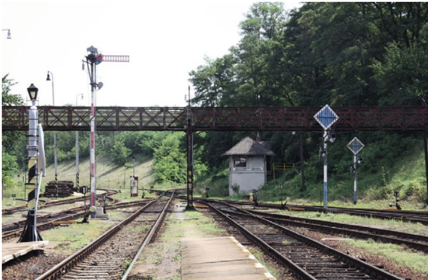
Stanice Hrušovany nad Jevišovkou s mechanickými odjezdovými a seřadovacími návěstidly, vpravo odbočuje trať do Hevlína, foto Josef Bosáček.
