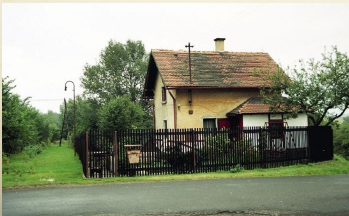
Strážní domek u bývalého přejezdu ve stanici Slapany v roce 1997, vlevo těleso koleje do Chebu a u plotu domku je ještě zachovaný stožár osvětlení, foto Petr Ovsenák.
