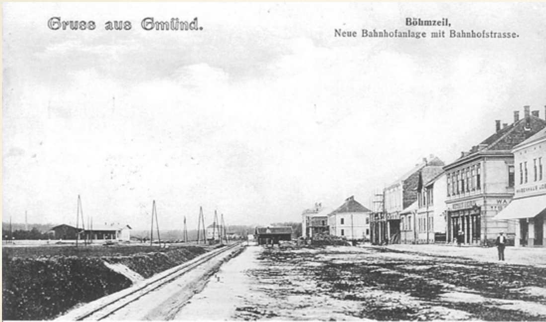
Dobová pohlednice Nádražní ulice v Gmündu (Českých Velenicích) před rekonstrukcí nádraží. V levé části obrázku je vidět úzkorozchodná trať do Litschau a Gross Gerungs ještě před rozbočením, sbírka Josef Bosáček.
