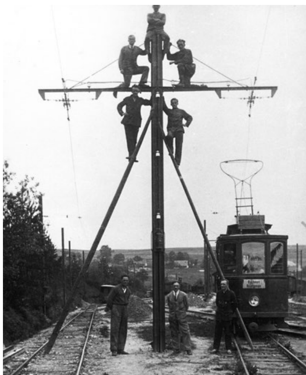
Druhá polovina třicátých let s tramvají číslo 5 v podobě pracovního vozu při stavbě nového napájecího sloupu v Rychnově u Jablonce n. N.
