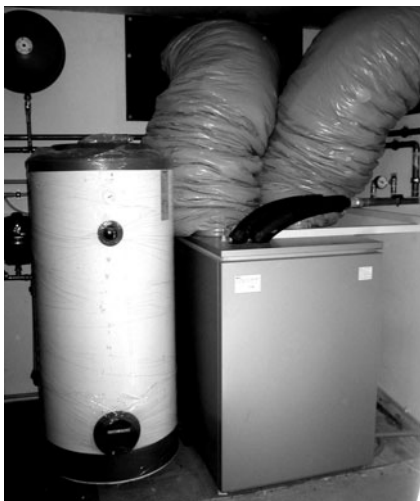
Obr. 4 Tepelné čerpadlo vzduch/voda – vnitřní provedení
