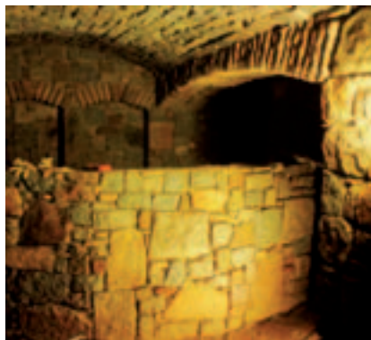
Obr. 3 Právě dokončený sklep
