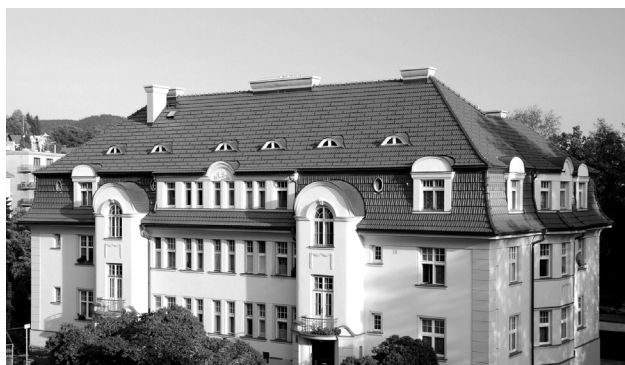
Obr. 2.7 Mansardová střecha – foto a schéma (zdroj: TONDACH Česká republika, s. r. o.)
