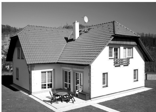
Obr. 2.5 Polovalbová střecha – foto a schéma (zdroj: TONDACH Česká republika, s. r. o.)
