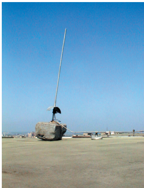
◀ Obrázek 2.3 Závada zapříčiněná dodavatelem – uložení jímací tyče hromosvodu na plynosilikátové tvárnici, která navíc volně spočívá na střešní hydroizolaci
